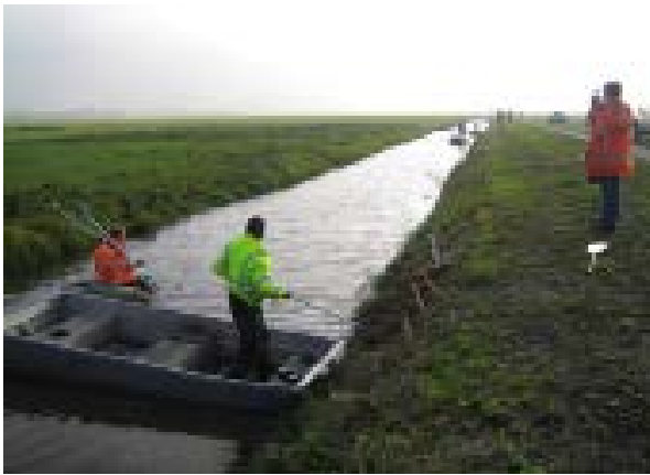
FOTO 1: LIGGING VAN DE PROFIELEN IS AANGEGEVEN MET PIKETPAALTJES.
