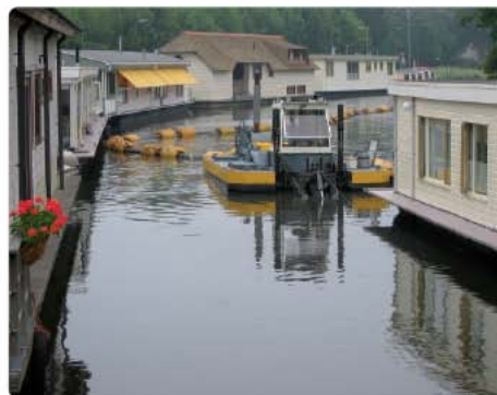
zulgerboot met knikarm om bagger onder woonboot te verwijderen
