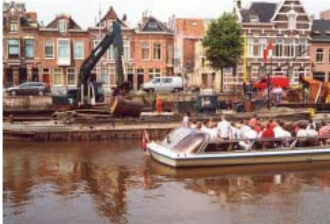
Excursie baggerwerk Diepenring te Groningen
